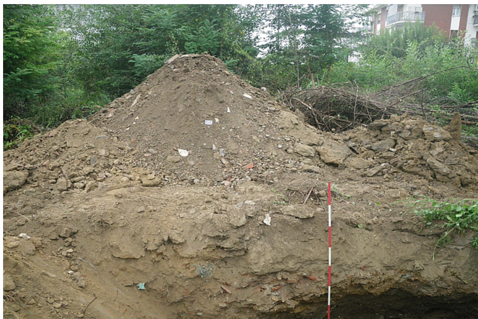
Illustrazione 20 Cumulo con il materiale estratto fino a -2,4m, a destra piccolo cumulo con materiale limoso sottostante.
