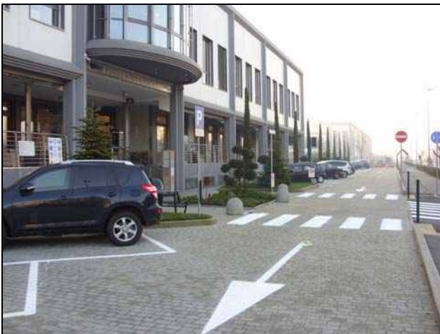
Parcheggi e viabilità interna del P.E.C. originario in fase di realizzazione attraverso l'utilizzo di pavimentazione in autobloccante.
